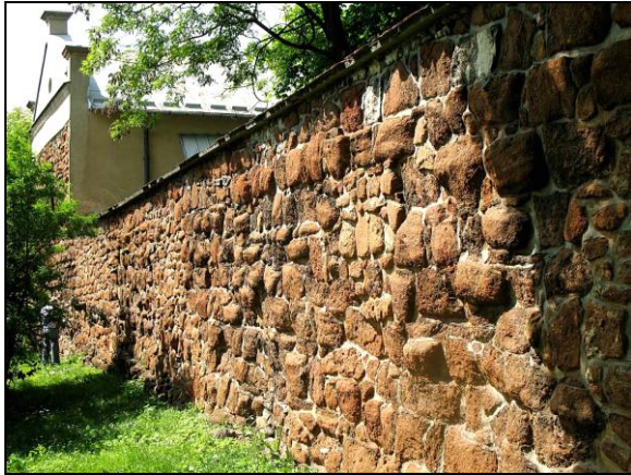
Fot. 10. Odrestaurowany mur miejski przy bazylice olkuskiej (fot. T. Szczypek) Photo 10. Restored town wall at Olkusz basilica (phot. by T. Szczypek)
