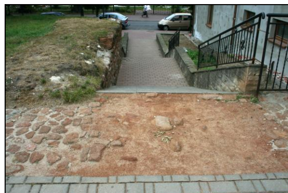
Fot. 24. Zlepieńiec parczewski nie jest zbyt wytrzymały na ścieranie (fot. J. Sypień) Photo 24. Parcze conglomerate is not abrasion-resistant enough (phot. by J. Sypień)
