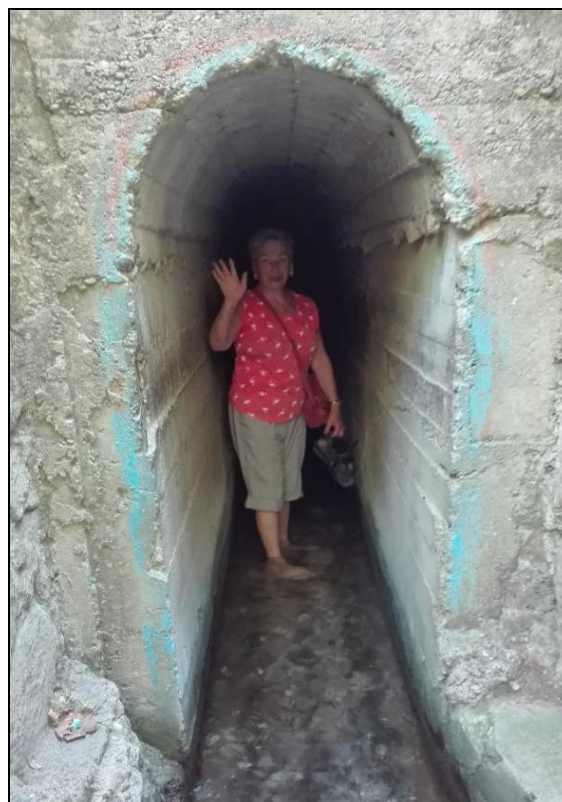
Фот. 3. Бетонный туннель для пропуска воды р. Луганис (фот. В. А. Снытко) Fot. 3. Betonowy tunel do przerzutu wody rzeki Lutanis (fot. W. A. Snytko) Photo 3. Concrete tunnel for water transfer of Lutanis river (phot. By V. A. Snytko)
