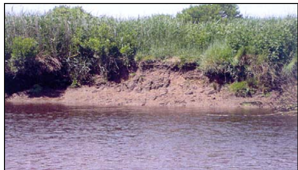
Fot. 9. Erozja boczna w korycie kanału La Tiech w sąsiedztwie delty Leyre (fot. E. Jaruchiewicz, 2008) Photo 9. Lateral erosion in the Canal La Tiech in the neighbourhood of the Leyre delta (phot. by E. Jaruchiewicz, 2008)
