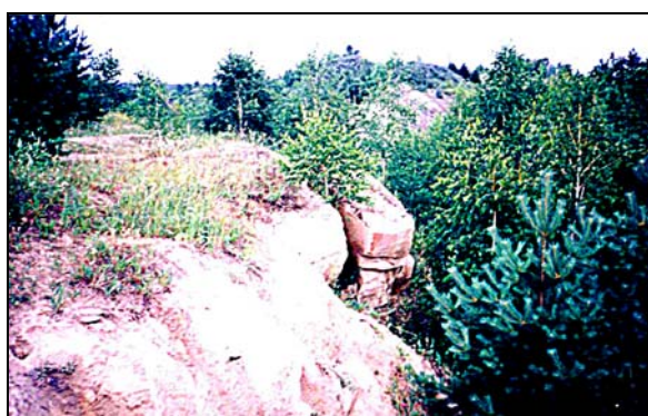
Photo 4. Detached blocks on the steep sidewalls of the open cast (phot. by I. N. Alyoshina) Fot. 4. Bloki skalne odspajające się od stromych zboczy wyrobiska (fot. I. N. Alioszina)
