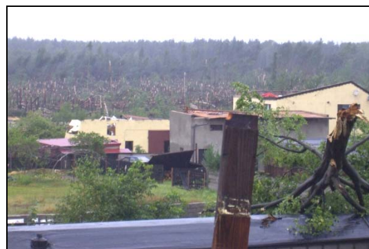
Fot. 1. Uszkodzone budynki mieszkalne w Kalinie (fot. K. Bartocha)
