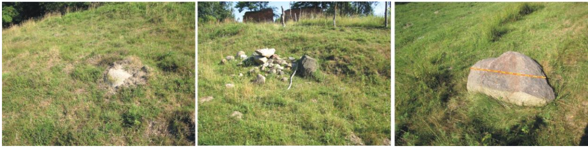
Fot. 11. Raszczyce. Próby stabilizacji osuwiska za pomocą narzutu kamiennego i dużych głazów eratycznych (fot. J. M. Waga)
