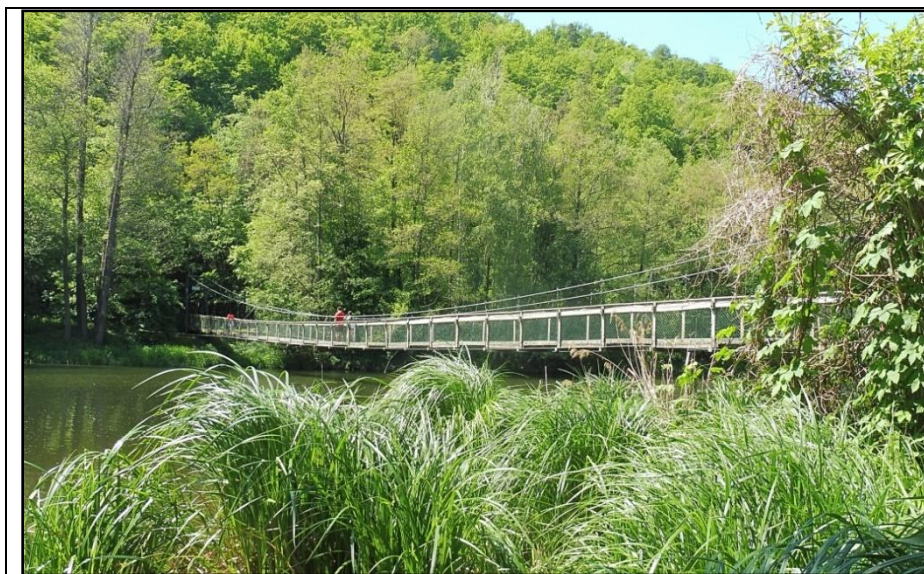
Fot. 24. Most linowy Šobeská lávka (fot. R. Kupka, 2022)
