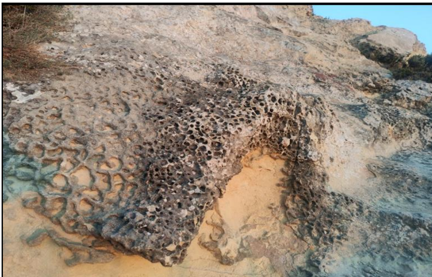
Fot. 10 – Фот. 10 – Photo 10: Tafoni na Gozo – Тафони на о. Гозо – Tafoni on Gozo (fot. – фот.: – photo by: M. Rosiński, 2021 – Internet)
